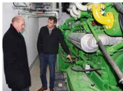
Das neue 526 kW BHKW wird über die Abwärme eines anderen BHKW permanent geheizt.
