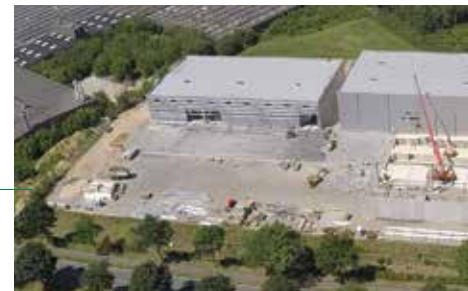
Baustelle der Kartoffelsortieranlage in Schwalmthal-Waldniel im Mai 2017.
